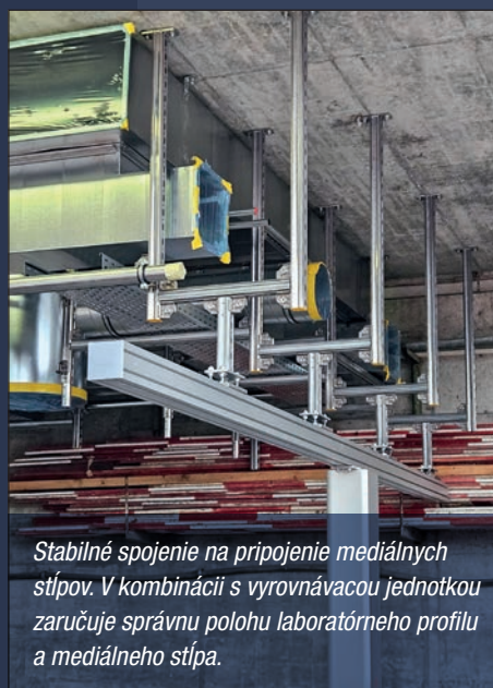
3-rozmerná montážna mriežka pre oblasti s vysokou hustotou inštalácie a vysokými požiadavkami na flexibilitu.
