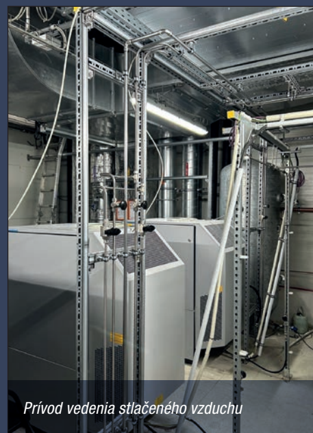
3-rozmerná montážna mriežka pre oblasti s vysokou hustotou inštalácie a vysokými požiadavkami na flexibilitu.
