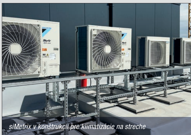
Systém siMetrix v spojení priamo na ocelovom nosníku
