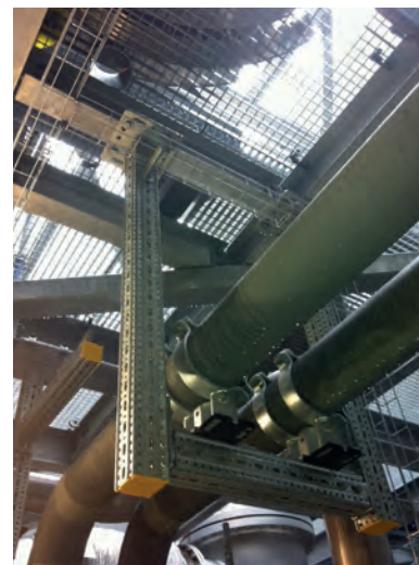
Archívna fotografia: Modulárny skrutkovaný systém siFramo na rýchlu montáž sekundárných oceľových konštrukcií
